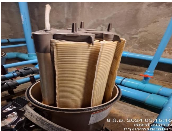
รูปที่ 37 เจ้าหน้าที่ทำความสะอาดเครื่องกรองน้ำสละเวย์น้ำ
