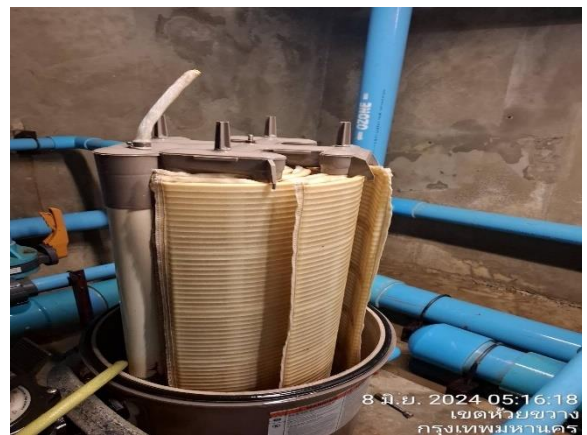
รูปที่ 37 เจ้าหน้าที่ทำความสะอาดเครื่องกรองน้ำสละเวย์น้ำ
